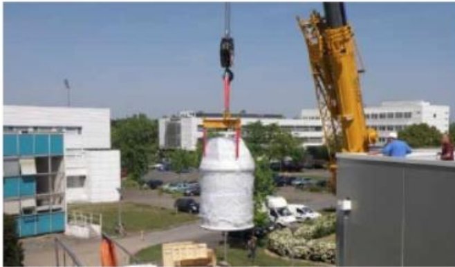
L'installation du RMN a nécessité l'usage d'une grue.
