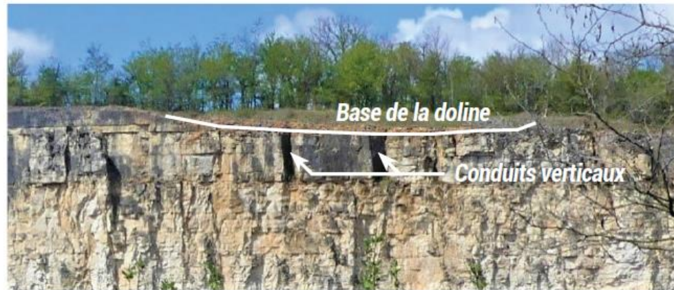
Doline et conduits verticaux, carrière de Pin (70) - BRGM
