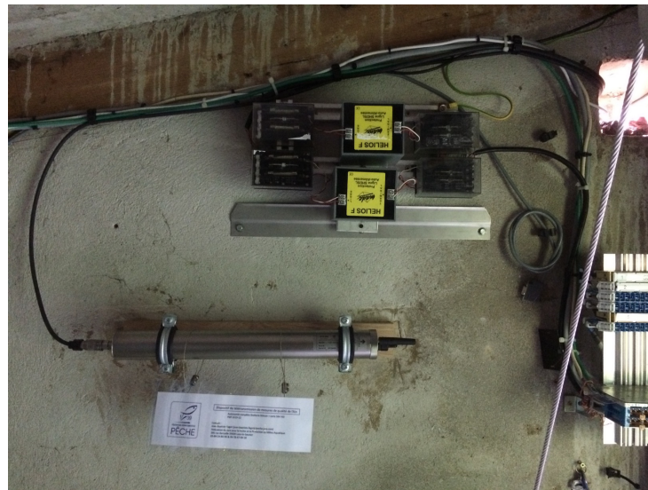
Modem installé dans un abri hydrométrique
