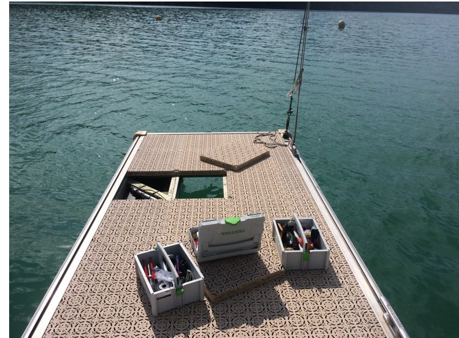
Implantation d'un piézomètre + modem – Retenue de Vouglans
