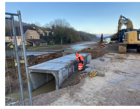
Ouvrage de fuite d'un bassin à Ranchot et pose d'un datot sur la Vèze d'Ougney à Taxenne
