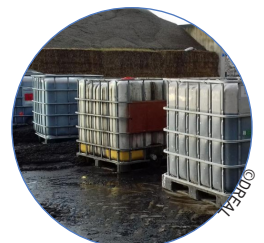
État du site après débordement des eaux de lessivage
