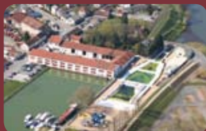
La relocalisation des services publics et la réduction de leur vulnérabilité. Ici, le parc routier départemental.
