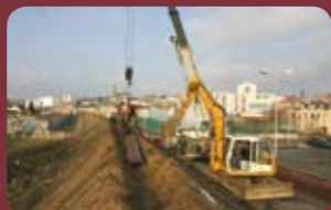
La sécurisation des digues et la création de déversoirs pour éviter les brèches.
