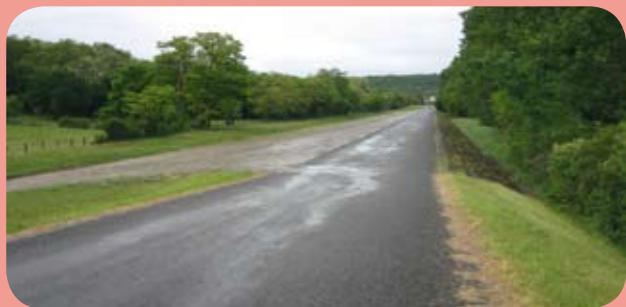
Déversoir du Guétin au Bec d'Allier
