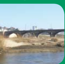
Après les travaux
