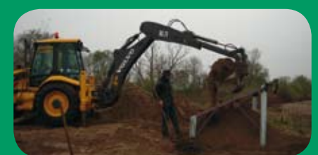
Travaux de traitement des rhizomes
