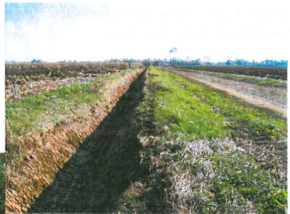
Fossé de drainage.
