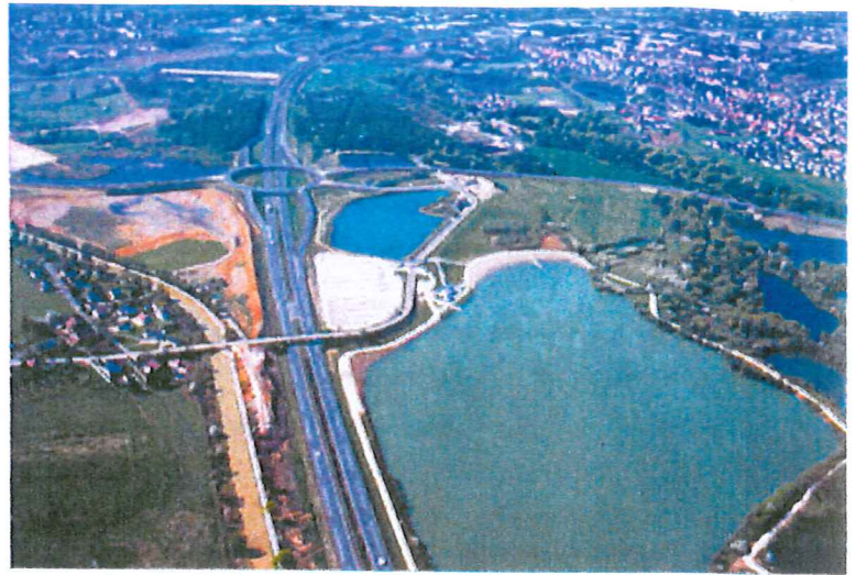
Vue aérienne de l'extrémité sud du système de bassins de rétention en amont de Montbéliard sur la Savoureuse : la base nautique de Brognard
