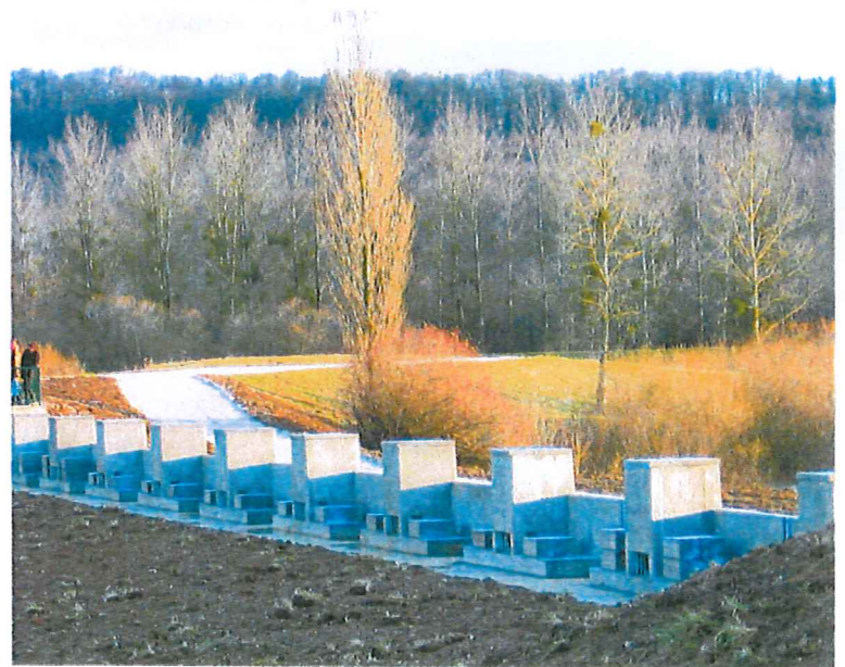
La digue fusible sur le bassin de l'Allan : une première européenne
