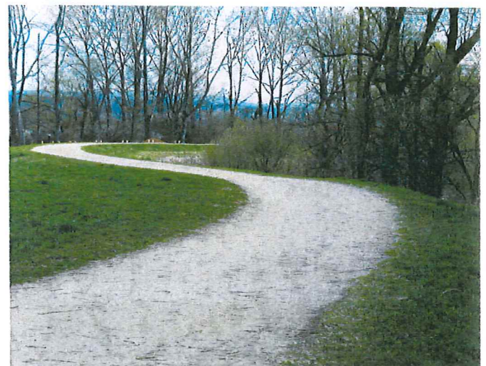
Digue longeant la Savoureuse à Nommay
