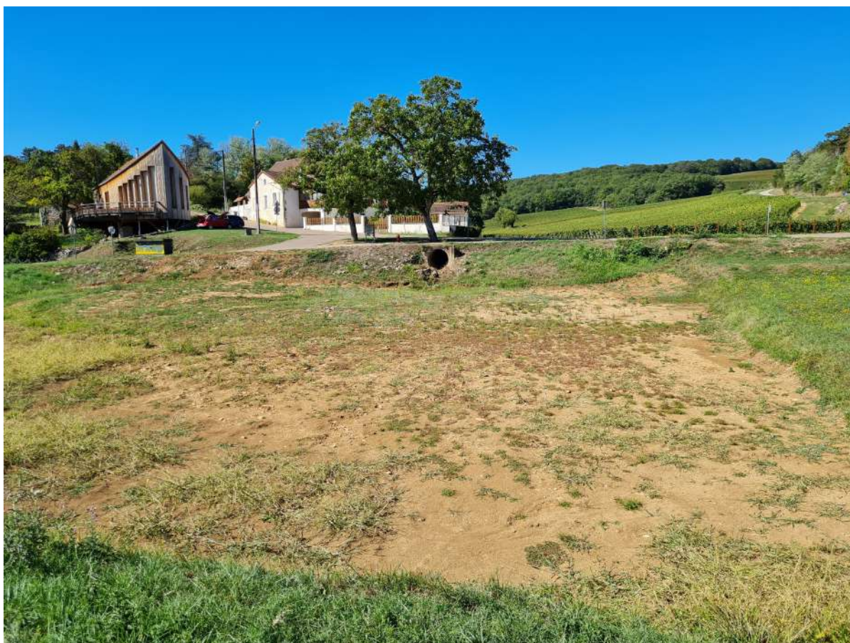
Illustration 45: Photo du bassin de rétention dans la zone est de Mercurey.
