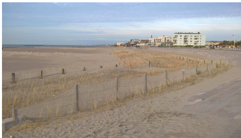
Illustration 11 : rechargement de plage, pose de filets brise vent et plantation d'oyats (techniques souples) pour protéger la digue des Alliés (technique dure) à Dunkerque (Cerema)
