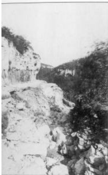
Vue de Gevrey-Chambertin après le tremblement de terre.
