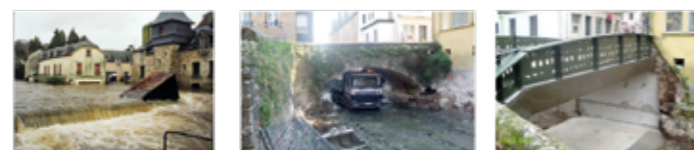
Le Pont Salé pendant les inondations de décembre 2000, avant et après les travaux réalisés en 2005-2006.
