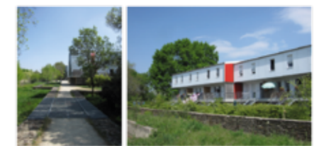
Fig. 16 - Sur le site, un exemple d'habitat d'architecture adaptée à l'île d'inondation : logements à Norkouse, La Plante de l'habitation, Bure Lombot architectes (2005-2006)
