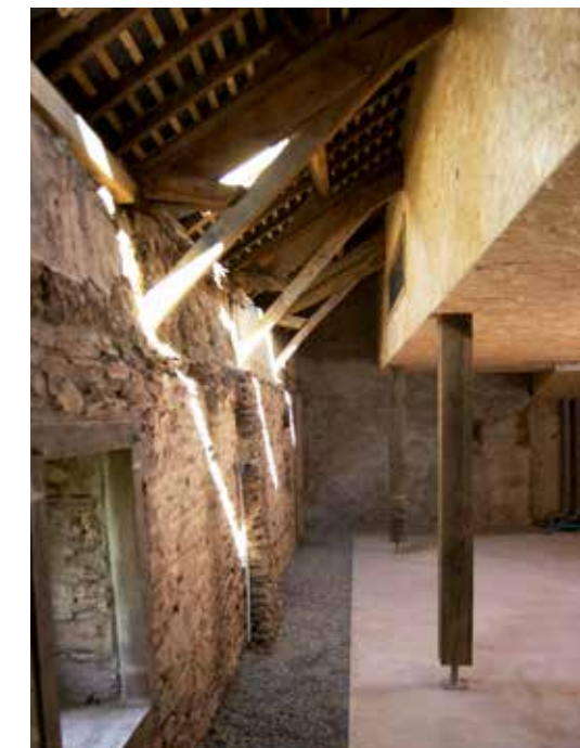
Éclairage zénithal dans les interstices du rez-de-chaussée
