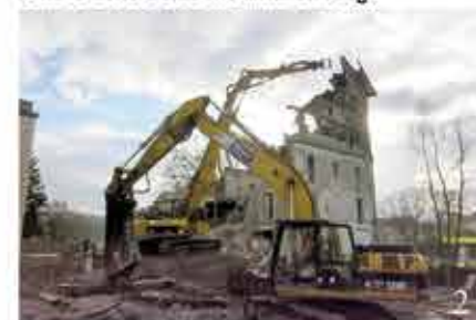
La démolition du moulin
