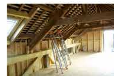
Vue de la structure intérieure de la cabane
