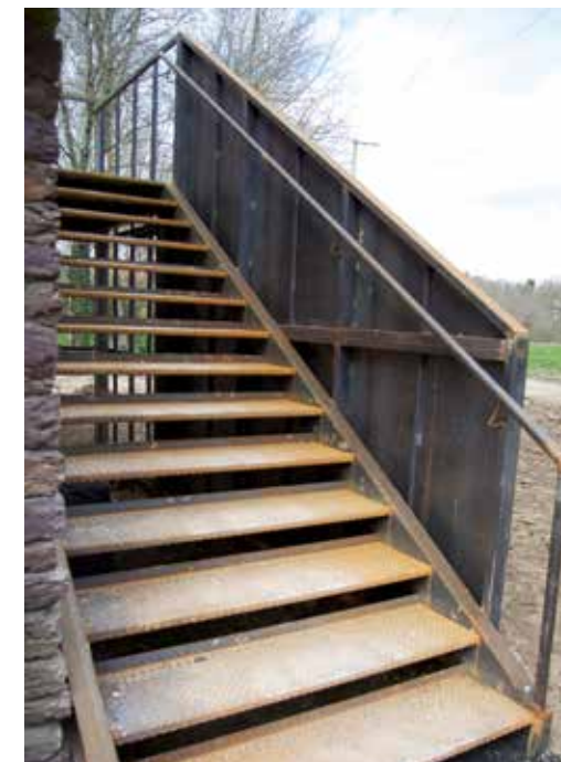
Escalier d'accès extérieur en acier brut
