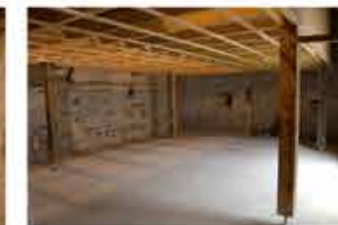
Structure de la sous-face de la cabane
