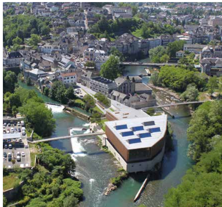
La médiathèque située au confluent des deux gaves d'Aspe et d'Ossau
