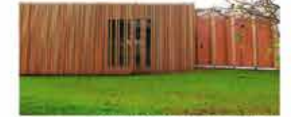
passerelle de liaison entre les deux cabanes
