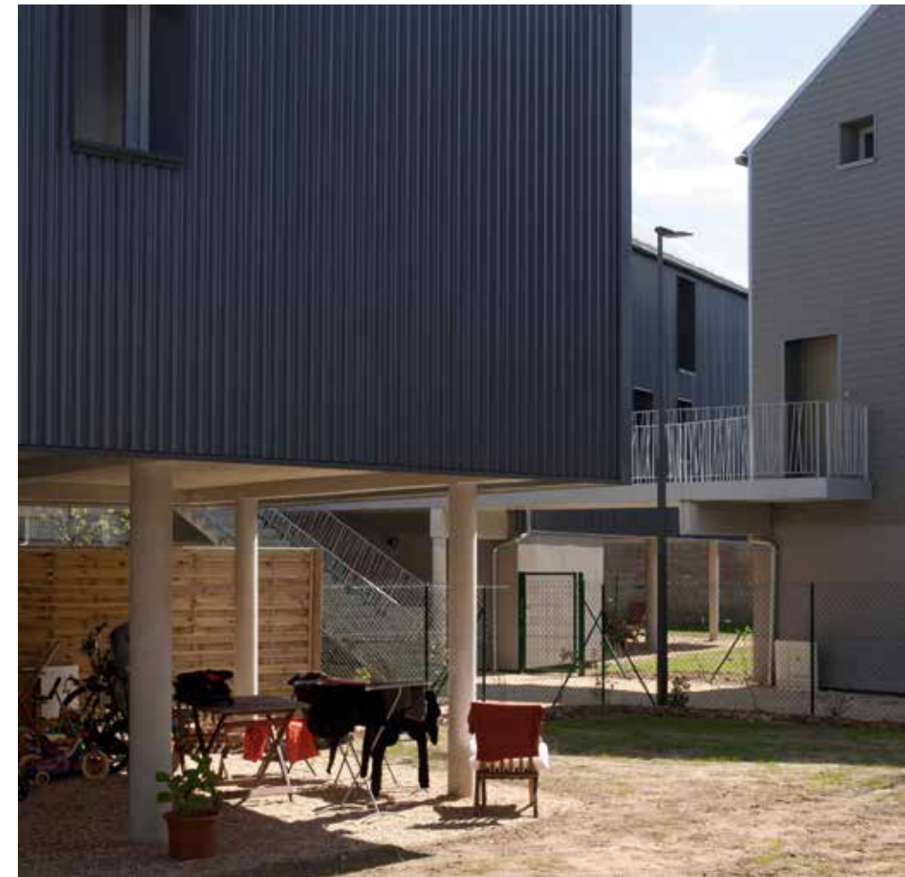
L'espace situé sous les pilotis est attribué à chaque logement
