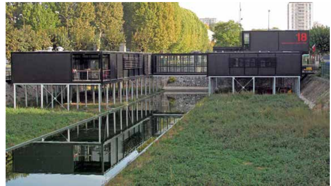
Le bâtiment se pose sur le site au moyen de fins pilotis
