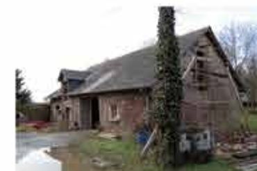
Ouverture dans pignon existant pour accès extérieur
